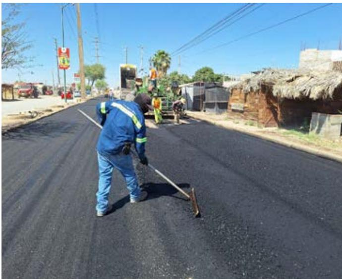
trabajos de reconstrucción de tramos dañados, recarpeteo y ampliación de la carpeta asfáltica con un espesor de cinco centímetros.
